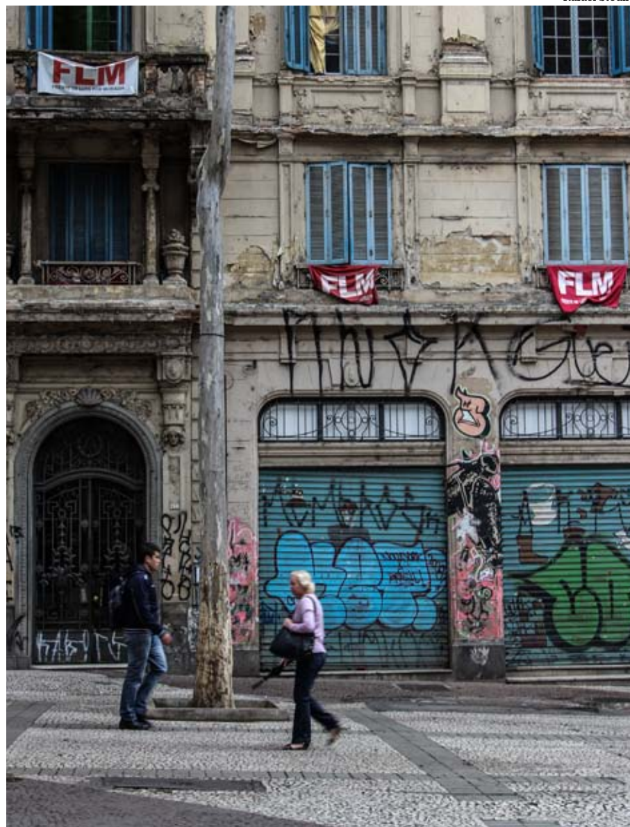
Prédio ocupado no Centro; alta dos aluguéis aumenta número de sem-teto
